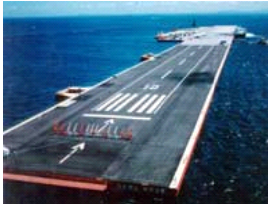
그림 15. 요코스카 앞바다에 건설한 부유식 해상공항
